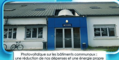
Photovoltaïque sur les bâtiments communaux : une réduction de nos dépenses et une énergie propre
