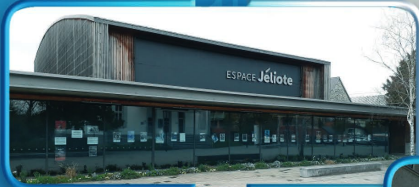
Achèvement des travaux initiés en 2000. Une belle réussite culturelle : la salle JÉLIOTE
